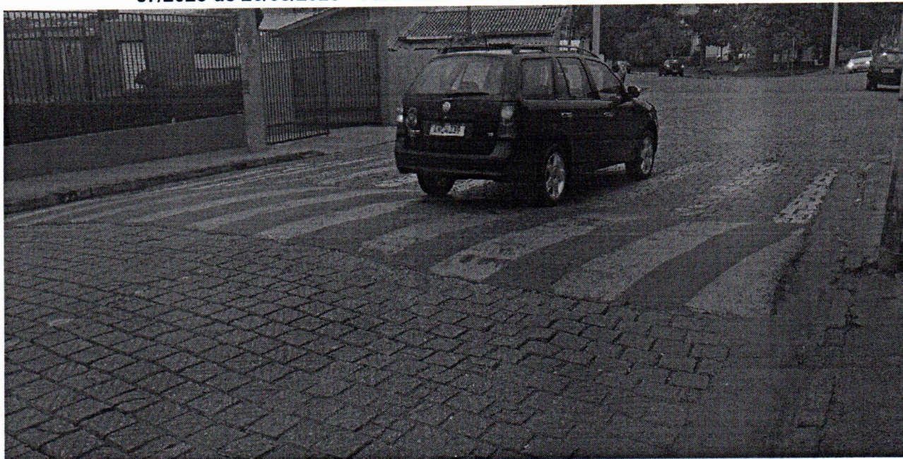
Serviço realizado no mês de abril de 2025 - Manutenção da Lombada com Pintura
