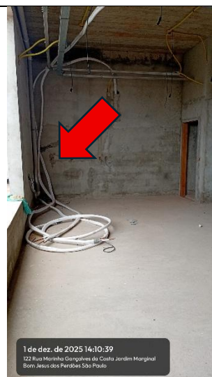
Imagem 10 – Tubulações de cobre de ar condicionado não concluídas
