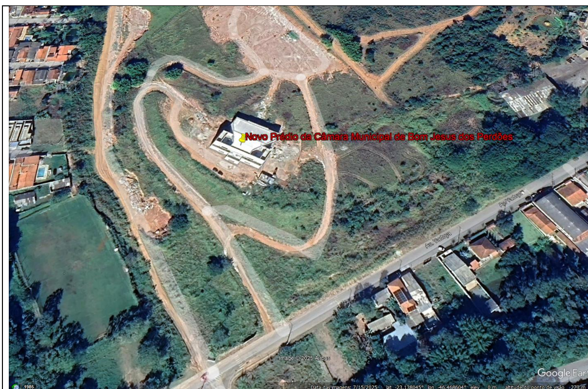
Novo Prédio da Câmara Municipal de Bom Jesus dos Perdões Latitude: -23.138555° - Longitude: -46.469384°
