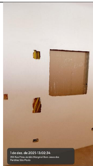
Imagem 08 – Rede de Elétrica e lógica não concluída
