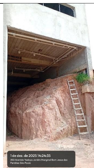
Imagem 04 – Fachada externa (necessário muro de arrimo)
