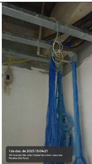
Imagem 07 – Rede de Elétrica e lógica não concluída
