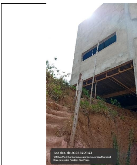
Imagem 03 – Fachada externa (necessário muro de arrimo)
